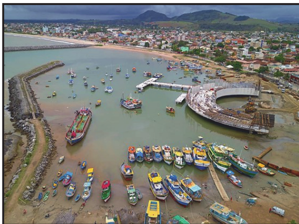
Figura 4: Obra do Terminal Pesqueiro em Construção
